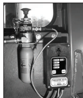
Sistema CHECKFIRE acoplado ao cartucho disparador com opção de atuação manual
